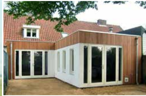
Nieuwbouw en verbouw
