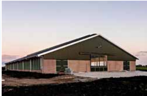
Ligboxstallen, loodsen en schuren
