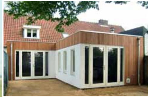
Nieuwbouw en verbouw
