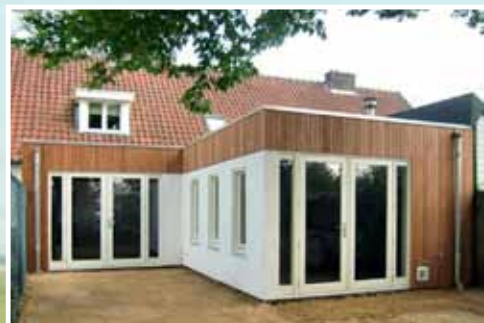
Nieuwbouw en verbouw
